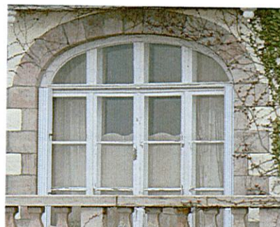
Double-fenêtre en bois (Boulevard de la mer), volets en PVC
