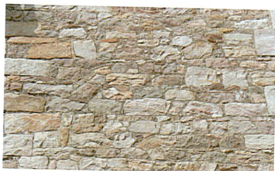
Mur grès rose pose rustique, joints réalisés au même nu que la pierre
