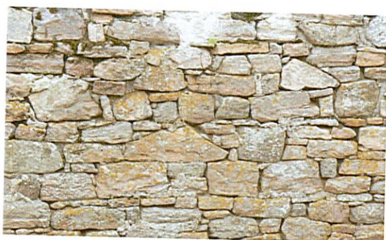
Mur grès rose pose rustique: joints inégaux en mortier (chaux ou terre), ici dégarnis
