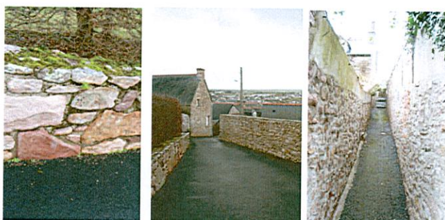
Enrobé noir couvrant entièrement les sentes piétonnes initialement en terre ou en gravier. Aspect noir triste, imperméabilisation et absence de végétation au pied des murs
