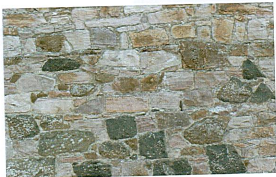
Mur grès rouge, schiste et grès rose: joints inégaux en mortier (chaux)
