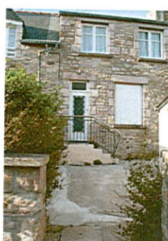
Chape en ciment imperméabilisant toute la cour
