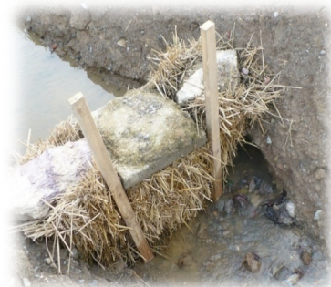
Photos d'emplacements de bottes de paille en phase travaux, dans un bassin d'orage et un cours d'eau
