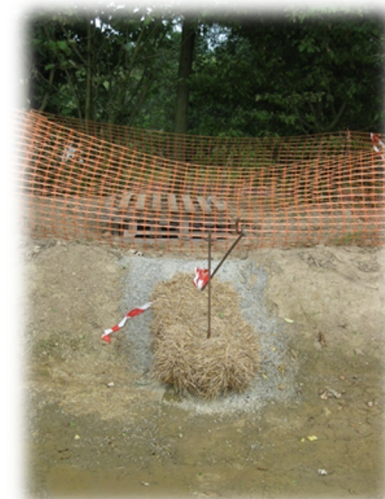
Photos d'emplacements de bottes de paille en phase travaux, dans un bassin d'orage et un cours d'eau
