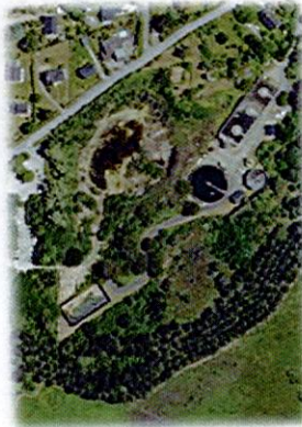
Vue aérienne de la STEP
