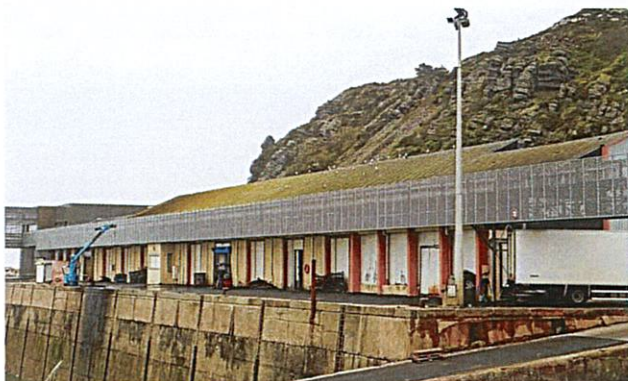
Grue démontée (source : Télégramme 23/01/2024)
