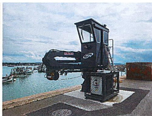
Nouvelle grue installée
