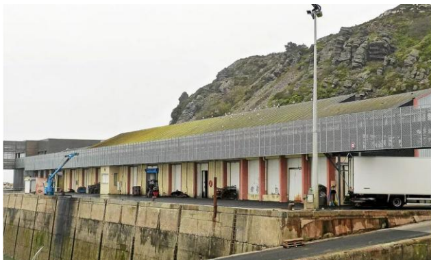
Grue démontée (source : Télégramme 23/01/2024)
