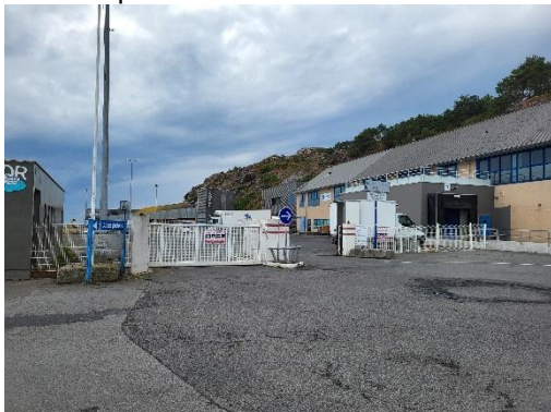
Le portail existant à supprimer
