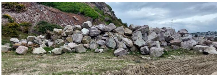
Blocs pour compléments (ballast et enrochements) sur môle
