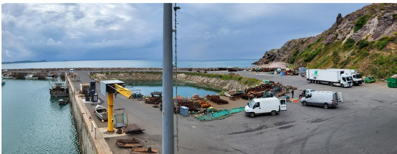
Vue n°3 depuis la passerelle sur le terre-plein et le bassin à sédiment
