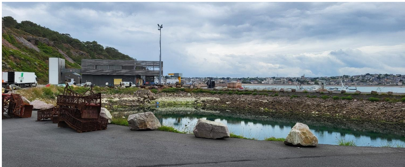
Vue n°4 sur le bassin à sédiment
