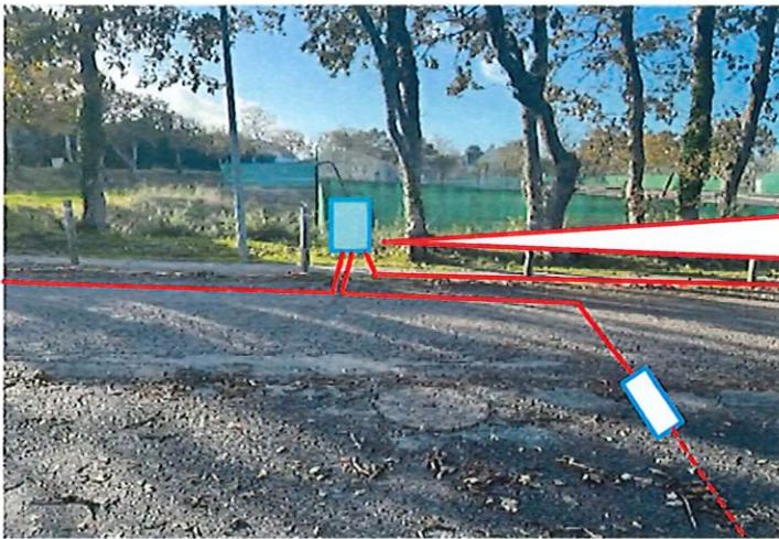
**POSE Coffret de réseau électrique sur socle H=75cm, L=53cm
