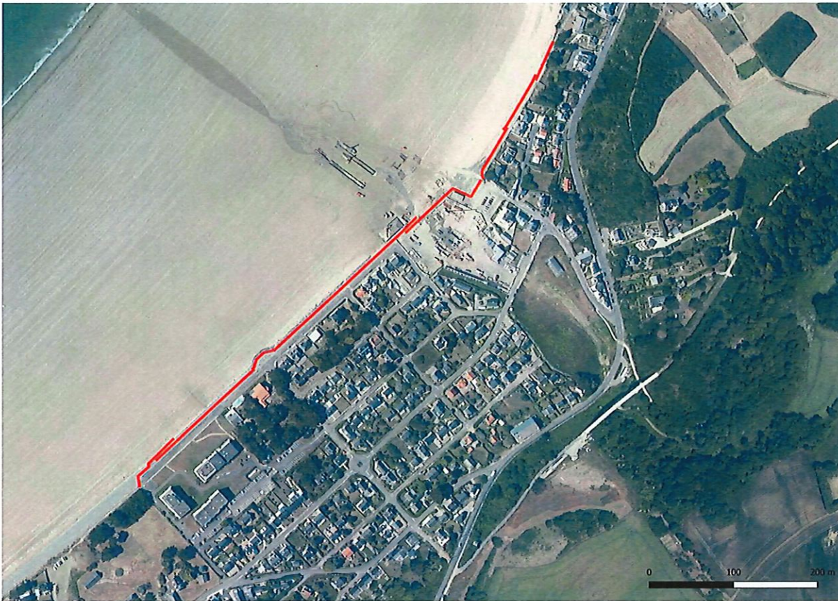
Fig.3 : Localisation de l'ouvrage maritime de Caroual à Erquy
