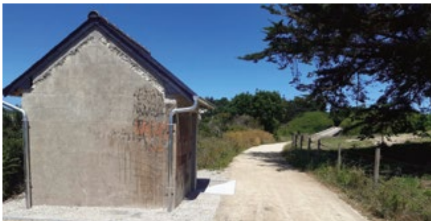
LA HALTE VIADUC EN COURS DE RÉNOVATION POUR L'INAUGURATION DU VIADUC
