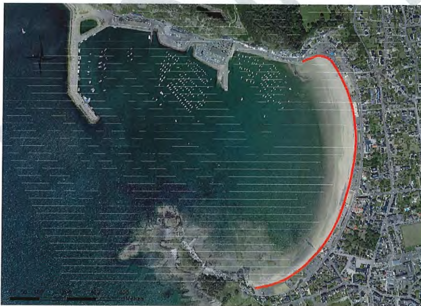
« Digue du centre à Erquy » (longueur de l'ouvrage concerné par la présente convention)
