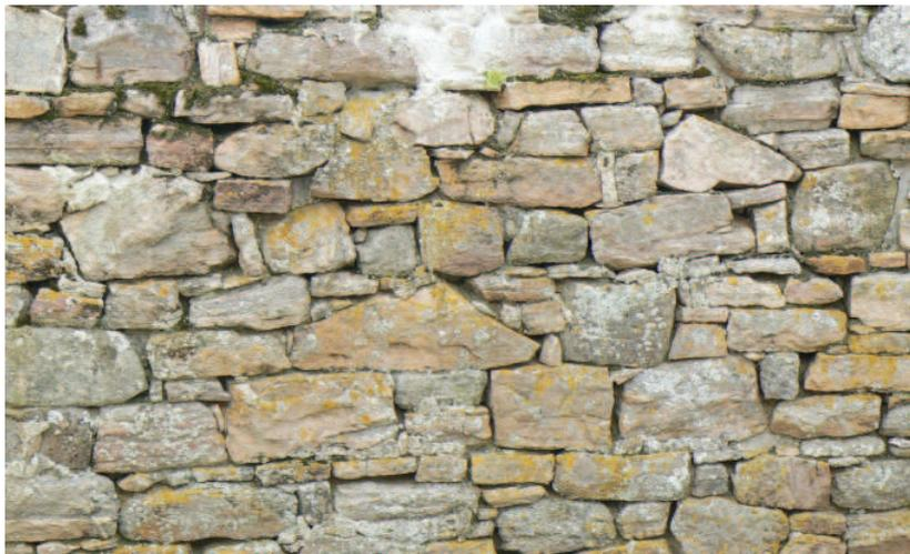
Mur grès rose pose rustique: joints inégaux en mortier (chaux ou terre), ici dégarnis
